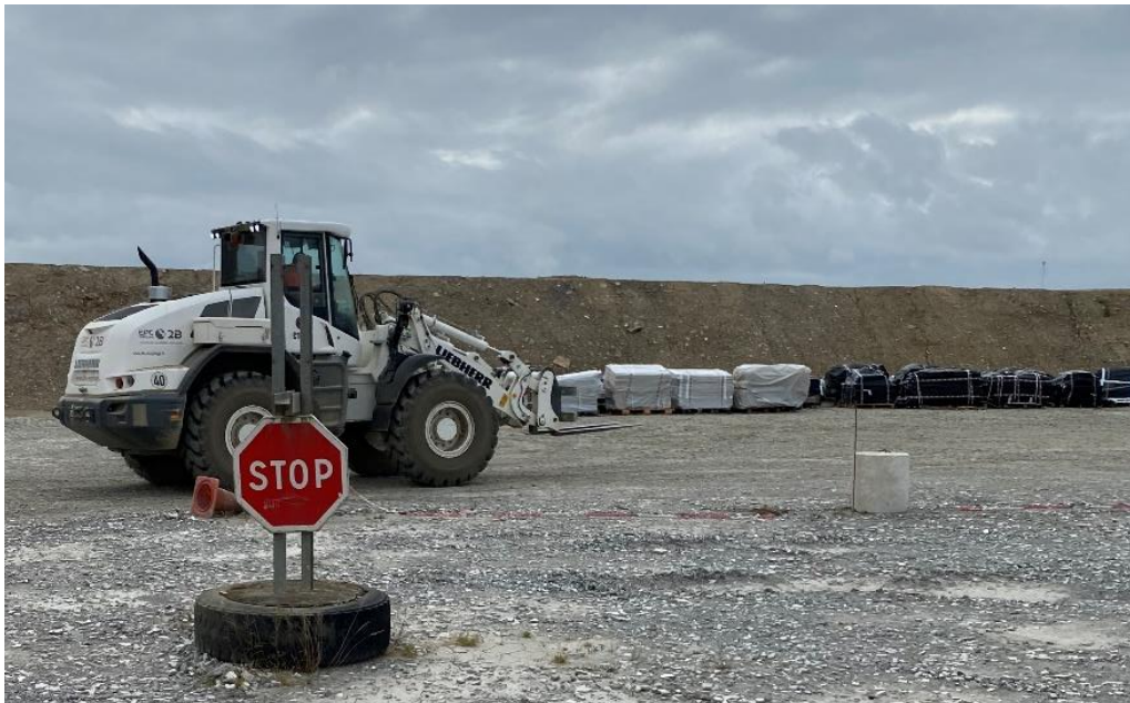
Photographie 5 : Chargeuse équipée de fourches servant au déchargement des palettes
